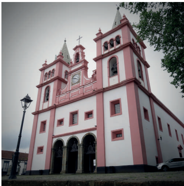
Figura 1. Edificio de la Catedral de Angra do Heroísmo, Isla Terceira, Azores, Portugal, que alberga, en su segunda planta, el archivo histórico
